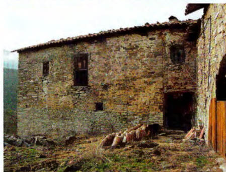
Figura 1. Façana principal de masia del baix Berguedà agrícola.
